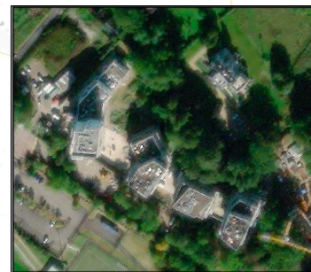
Résidences d'habitat collectif à Saint-Herblain - 90 lgts/hectare
