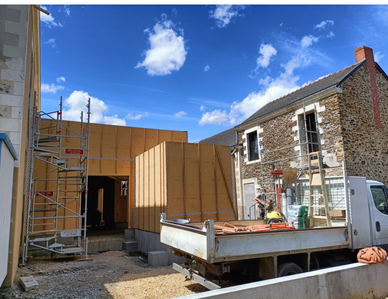
Chantier de rénovation de l'ancienne mairie en Pôle médical et espace de coworking - Les Touches © CC Erdre et Gesvres
