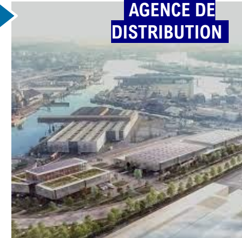
Hôtel de Logistique Urbaine multi-opérateurs en construction sur le Port de Lyon
