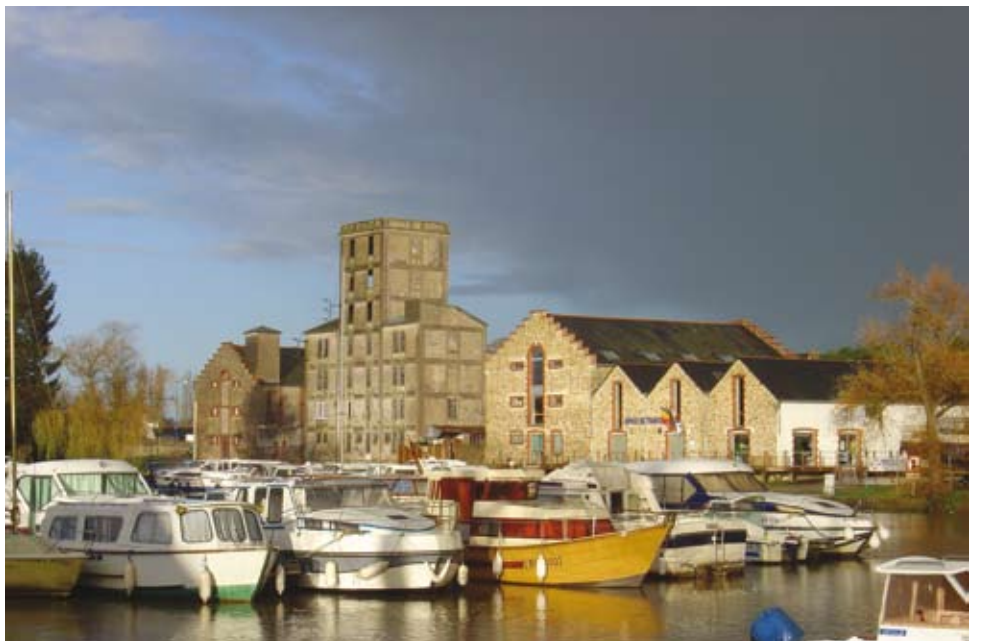
La minoterie « Hennebique » à Nort sur Erdre
